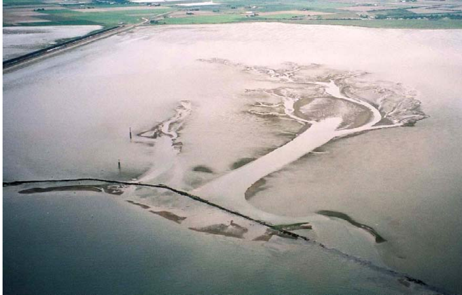
Figure 20. Protection à crête et partie en aval du chenal d'écoulement de la marée.
