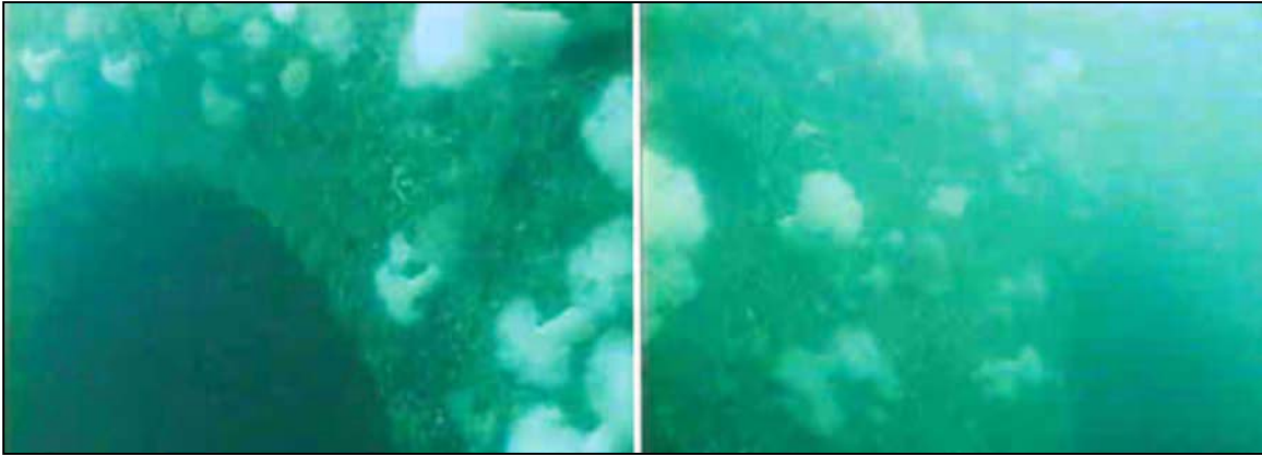
Figure 23. Paroi du caisson et entrée du refuge.
