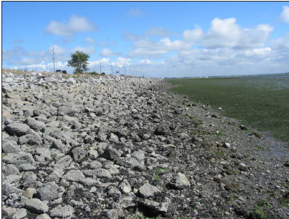
Figure 1. Enrochement de la rive Est
