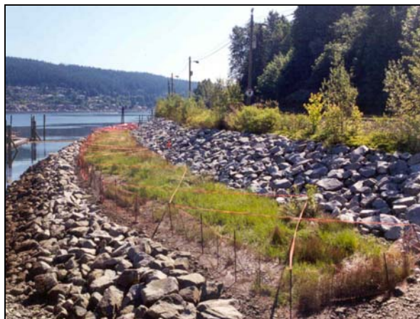
Figure 10. Marécage saumâtre dans un enrochement avec des arbustes plantés en amont sur l'arrière littoral.
