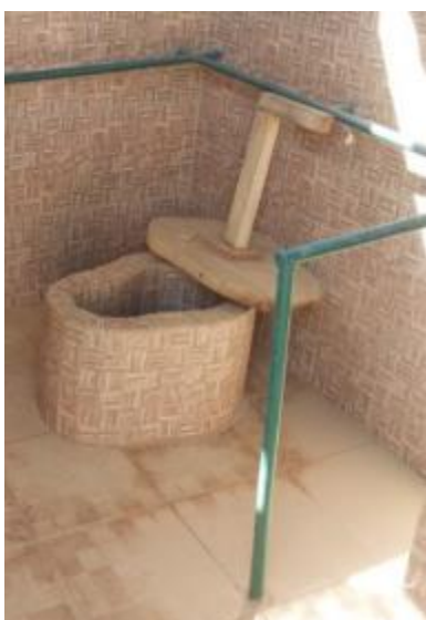
Photo 9 : CS Same oulof : latrine handi spécifiques
