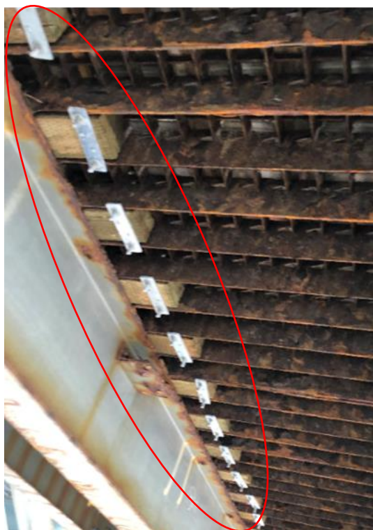
Figure 10-4: Coins en bois pour fournir un soutien à court terme des caillebotis.
