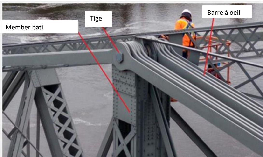
Figure 10-2: Principales structures du pont Alexandra
