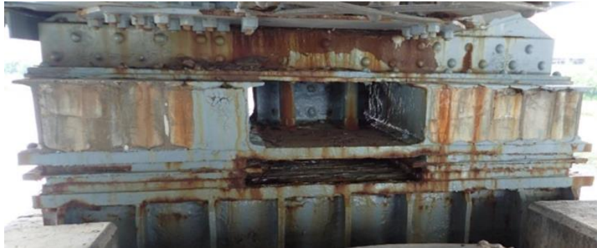
Figure 10-8: Appareils d'appui
