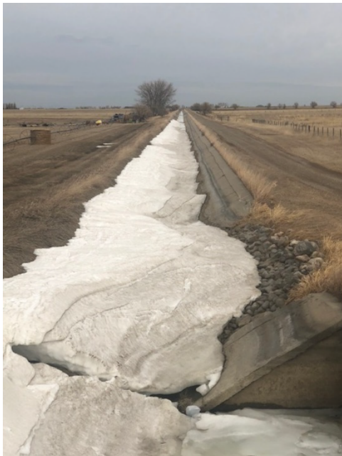
Photo 2 Phase 1 – Début du drain du chenal, vers l'ouest
