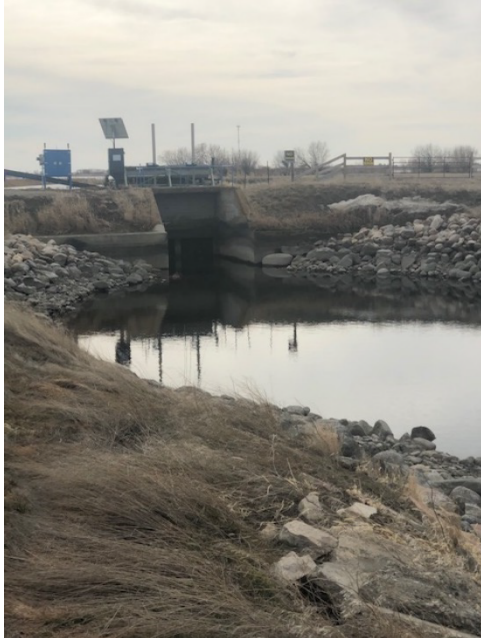
Photo 1 Phase 1 – Ouvrage de vidange du Taber Lake
