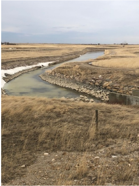
Photo 7 Phase 3 – Canal d'entrée du canal principal du DISMR vers Horsefly Lake Reservoir
