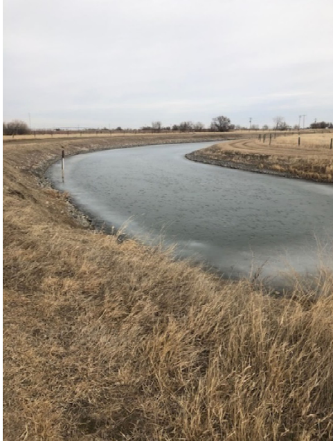
Photo 5 Phase 2 – Chenal de vidange des eaux de Horsefly, vers le nord
