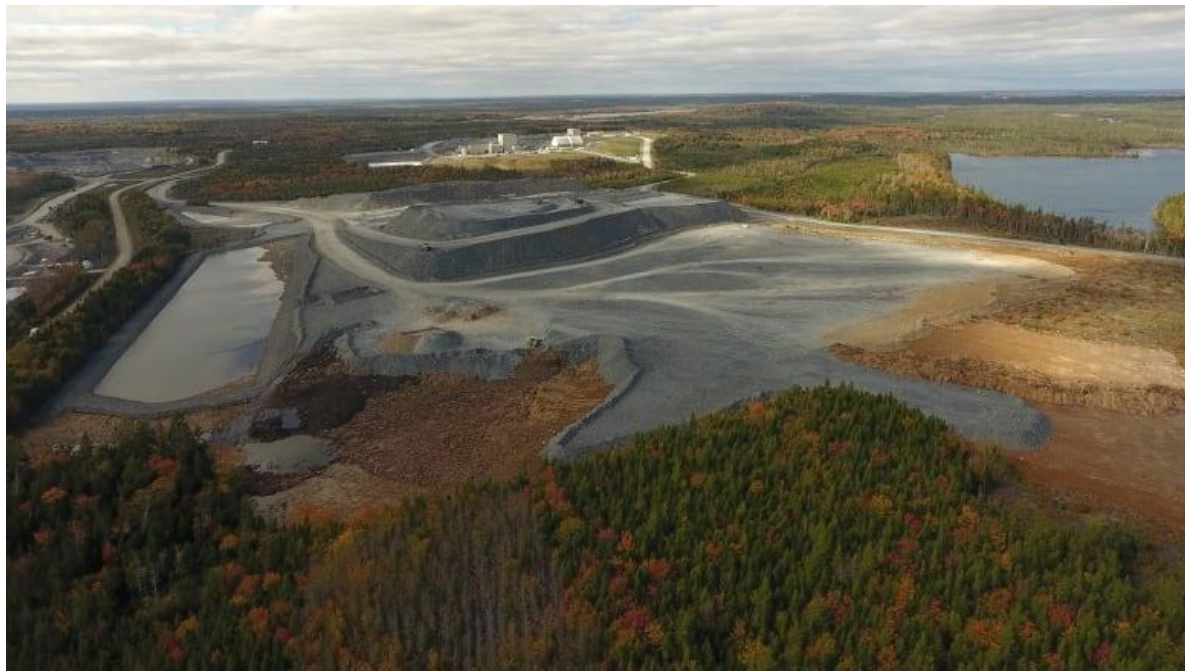
Figure 2-10 Bassin de décantation typique
