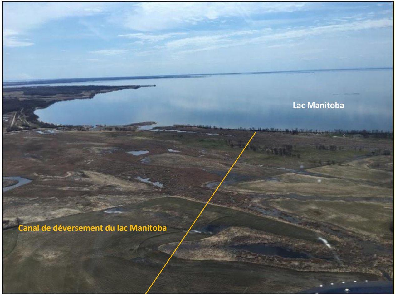
Photo 1. Entrée du canal de déversement du lac Manitoba le 31 août 2017, vue vers le sud-ouest d'environ 14 U 5302187 E 5681941 N (axe longitudinal proposé en jaune).
