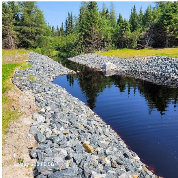
PHOTO 4 Enrochements de protection en amont du ponceau sous la route Billy-Diamond – 6 août 2025
