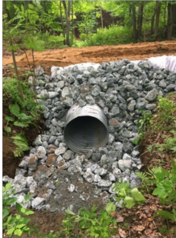
Clé d'ancrage recouverte de pierres
