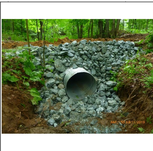
Talus correctement enroché et clé d'ancrage à la base
