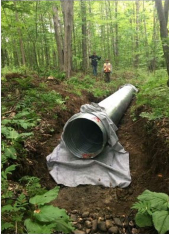
Installation de la toile pour la clé d'ancrage
