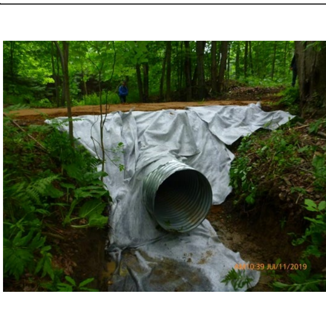
Installation de toile géotextile avant enrochement
