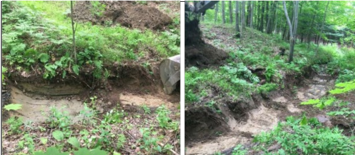
Tranchée sous le thalweg représentant 20 % du dimensionnement du ponceau sur ruisseau intermittent.
