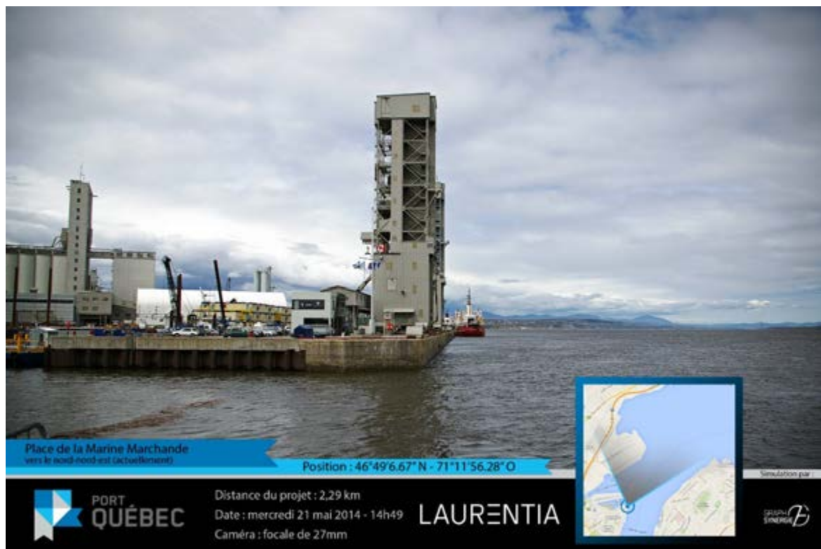
Figure 19-8 Vue à partir de la Place de la marine marchande (avant)
