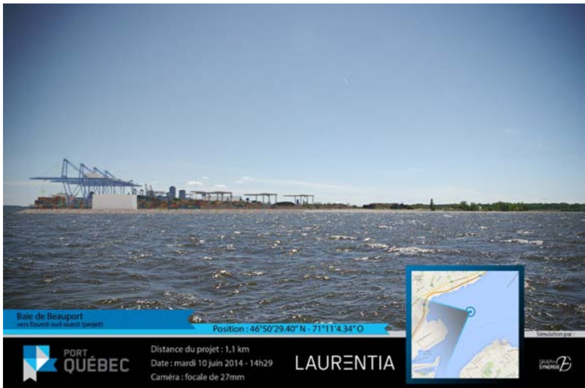
Figure 19-27 Vue à partir du fleuve, secteur de la Baie de Beauport (après)
