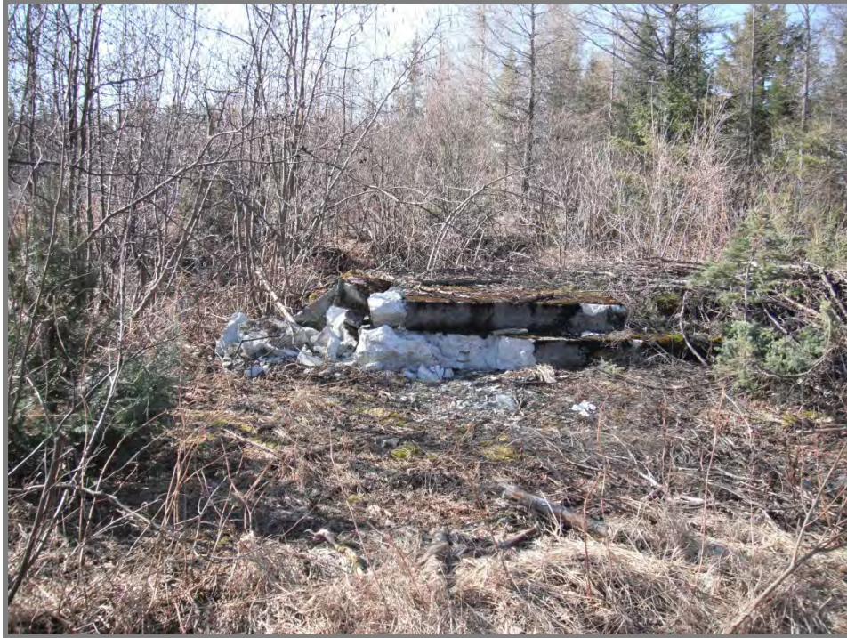
Photo 3 : Infrastructure de l'ancienne mine Akasaba au nord-est du site à l'étude
