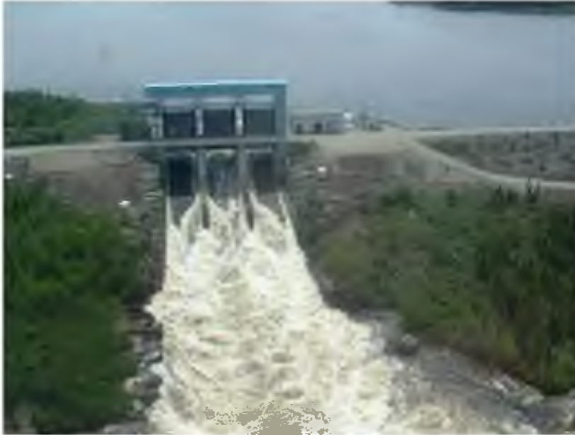
Photo 13-6 : Ouvrage régulateur de la Sarcelle
