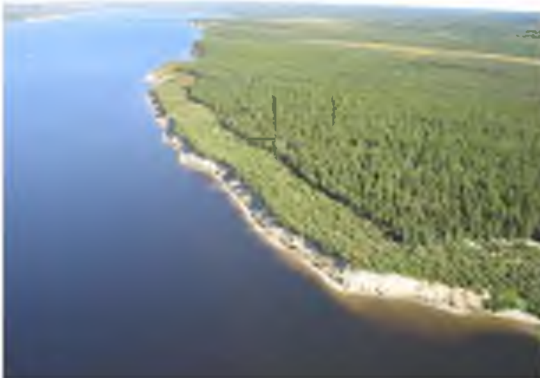
Photo 13-5 : Réservoir La Grande 1 – Talus d'éboulement d'environ 6 m de hauteur en bordure d'une terrasse de sable – Rive sud, vue vers l'amont depuis le PK 53
