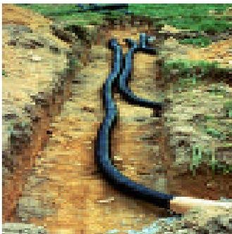
Figure 3.9 Remblaiement d'une tranchée de drainage
