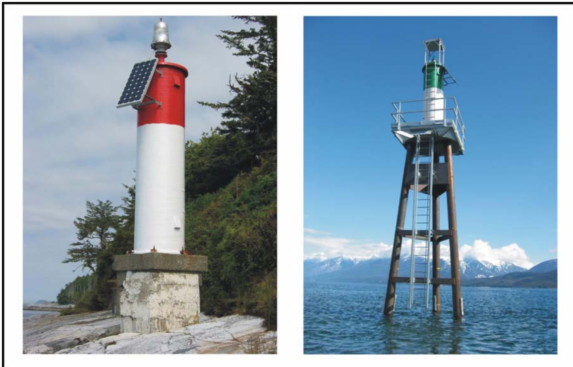
Figure 1. Structure en béton et structure à pieux typiques assujetties au REPS
